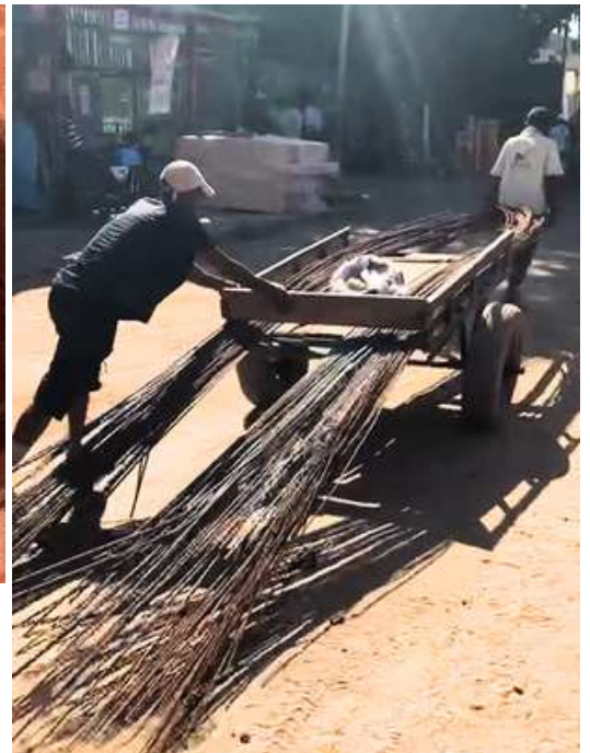
Staal vir betonversterking word aange"ry" na die bouperseel.
